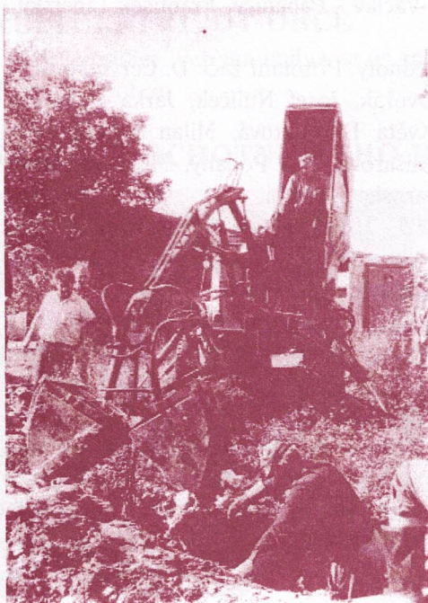
Pokládání kanalizace před stavbou kulturního domu
